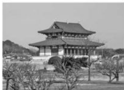
復原された大極殿正殿
